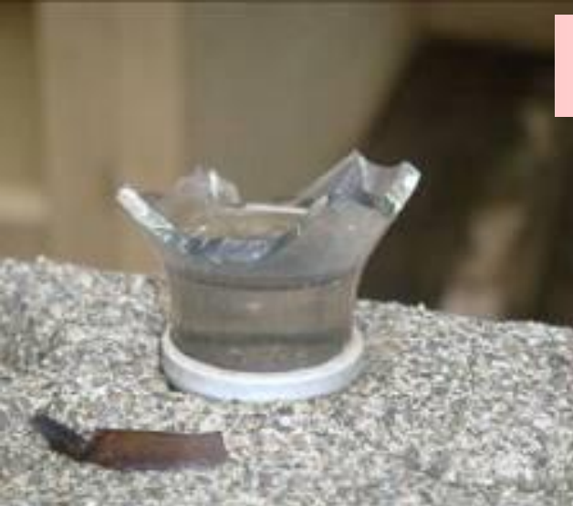
防竊盜圍牆碎玻璃
