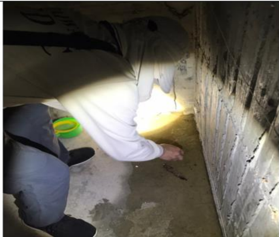
時間：112 年 6 月 17 日↵ 地點： 東區崇吉一街新都心建築工地 /地下室 2 樓↵ 說明：D 棟積水處孳生病媒蚊幼蟲約 15 隻↵
