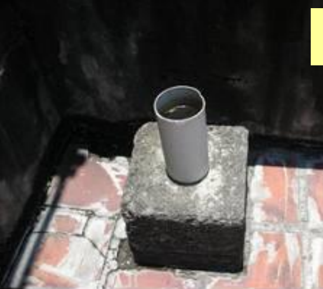
水泥樁上之水管
