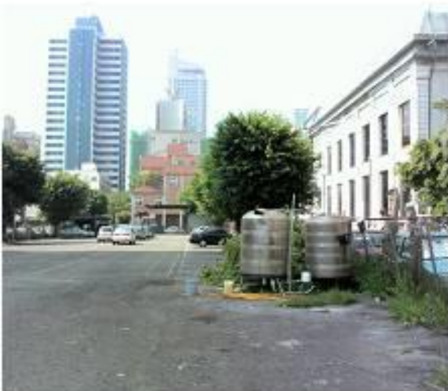
停車廠水塔無蓋
