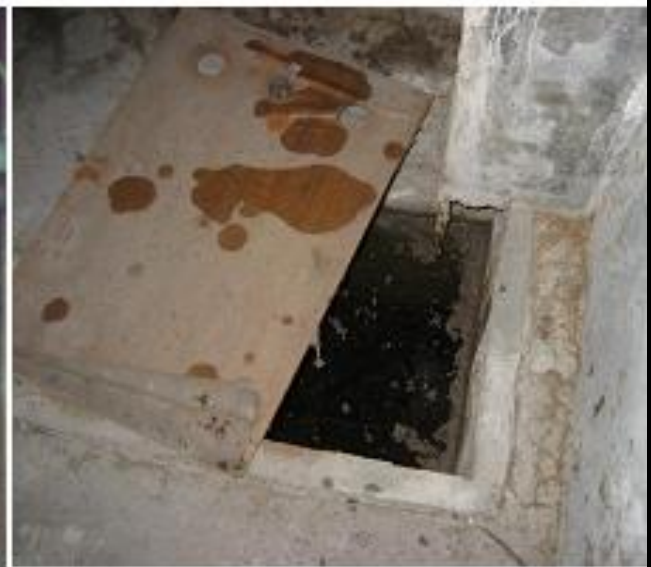
地下室污水池
